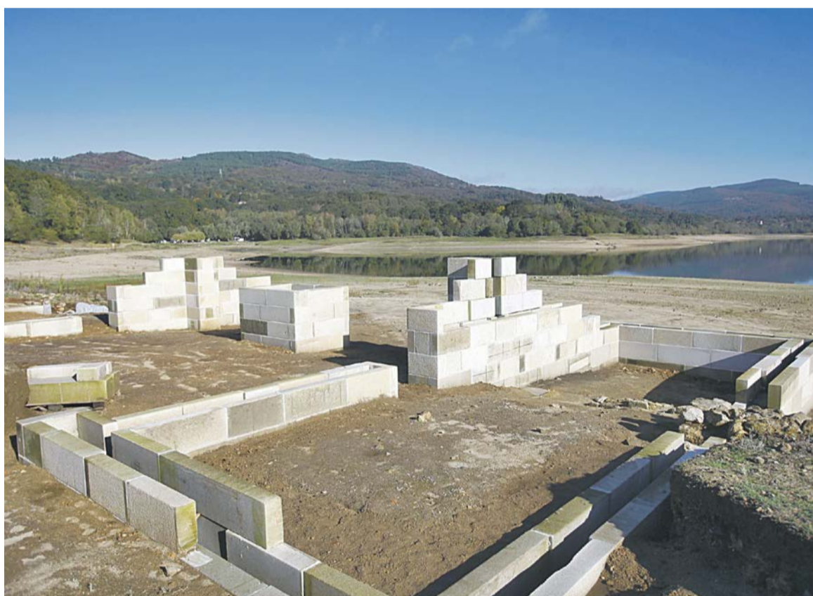
Tras la excavación, los operarios trabajan ya en la reconstrucción de la puerta Praetoria.
